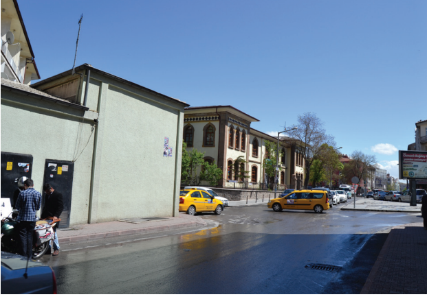
Konya Ahi Evran Zaviyesi'nin yerinde elektrik trafosu bulunmaktadır. (solda)
